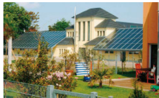
Solarthermische Anlagen als Sonnen- und Regenschutz; Quelle: BMU
